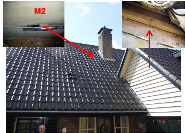
2. Vlakke platen als dakbeschot op de woning en de garage .
